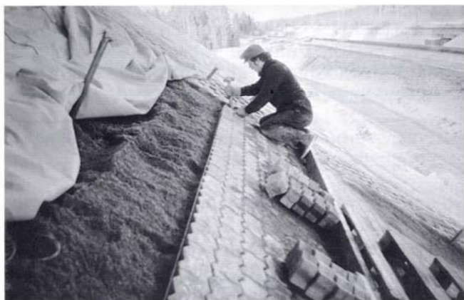
Kuva 12. Varvin vaakasuoruus tarkistetaan asennuslangalla.
