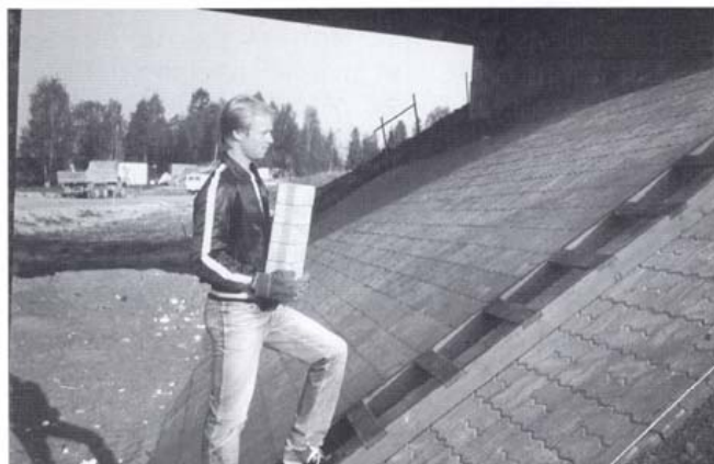
Kuva 13. Betonikivet kannetaan asennuspaikalle.
