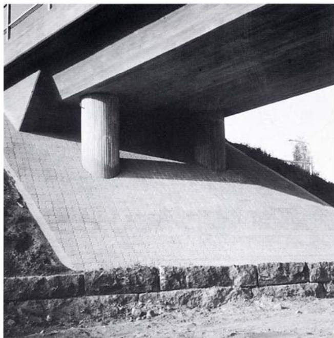
Kuva 1. Sopusuhtainen ja hyvin tehty betonikiviverhous etuluiskassa.
