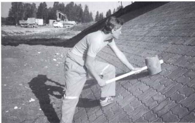
Kuva 16. Verhouksen tiivistystä puunuijalla.
