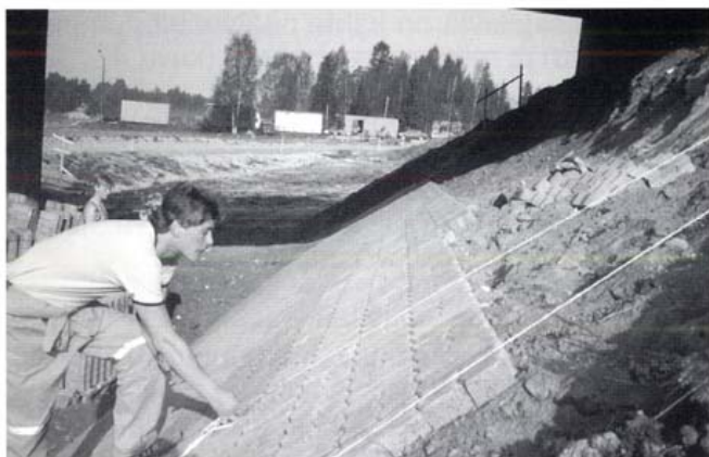
Kuva 7. Kaltevuus tarkistetaan asennuslangalla.
