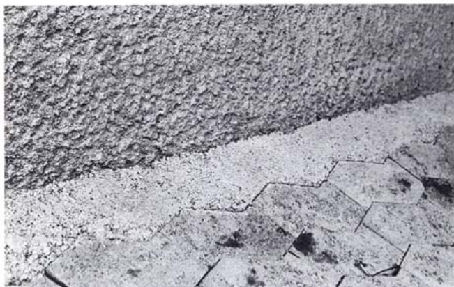
Kuva 17. Verhouksen reuna vahvennetaan betonikaistalla.
