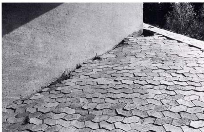
Kuva 20. Sortuma betonikiviverhouksen reunassa.
