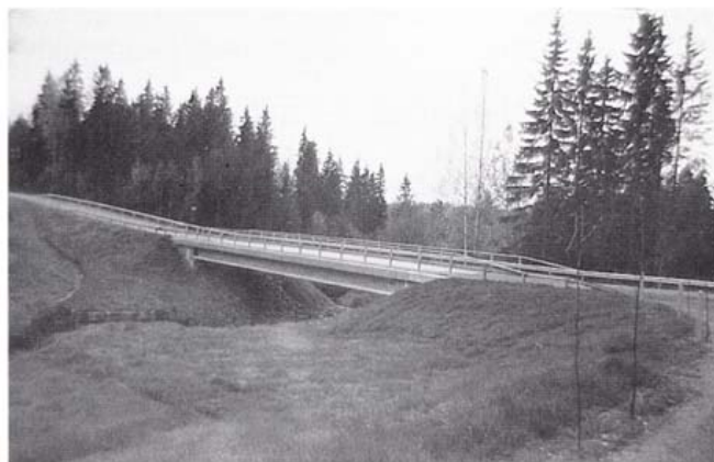
Kuva 3. Luiskat on muotoiltava loiviksi.
