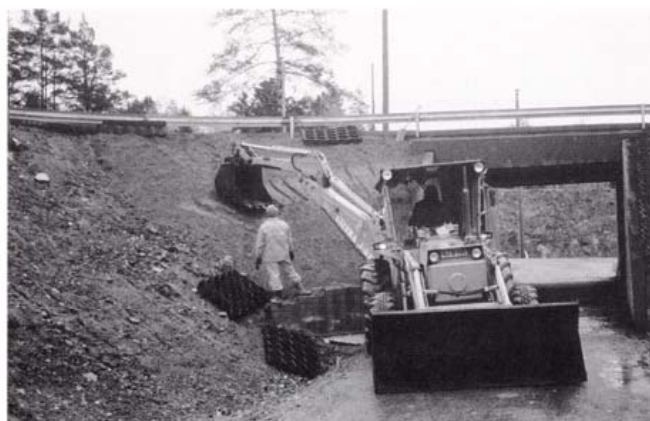
Kuva 5. Verhousarinan tekoa konetyönä.
