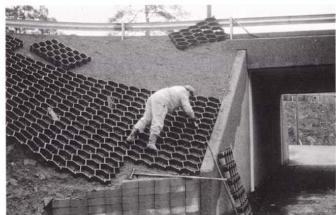
Kuva 8. Luiskakennoa kiinnitetään terästapeilla.
