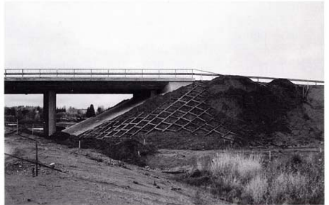
Kuva 10. Pääosa mullasta kasataan yläosaan.
