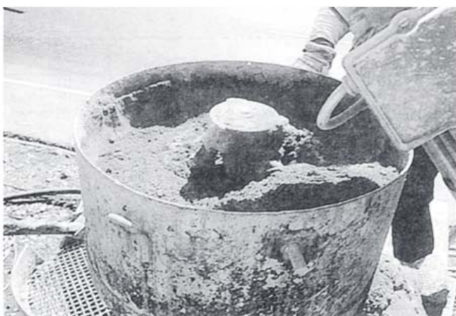
Kuva 2. Betonimassa valmistetaan betoninsekoittajalla.
