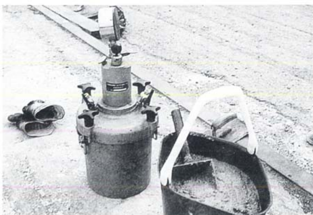
Kuva 3. Ilmamäärä mitataan työmaalla.
