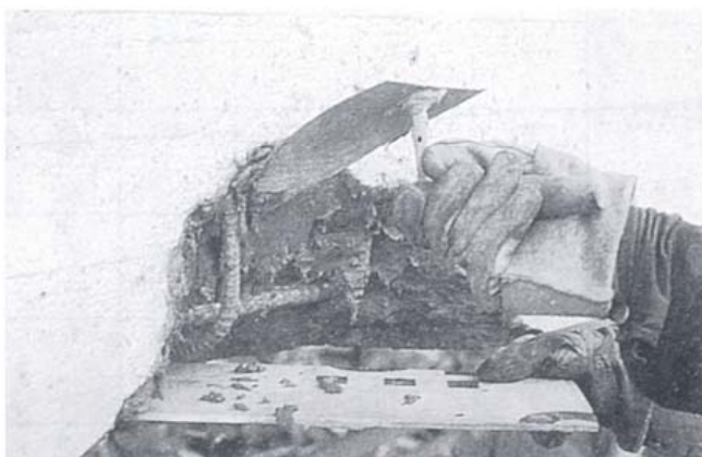
Kuva 1. Paikkausta valumattomalla paikkauslaastilla.
