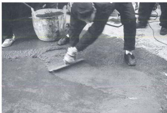
Kuva 3. Eristysalustan tasoitusta.
