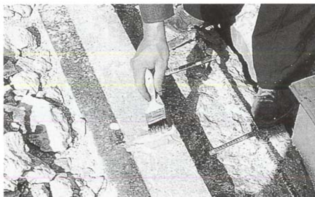
Kuva 3. Imeytystä käytetään yleensä halkeaman täyttämiseen.
