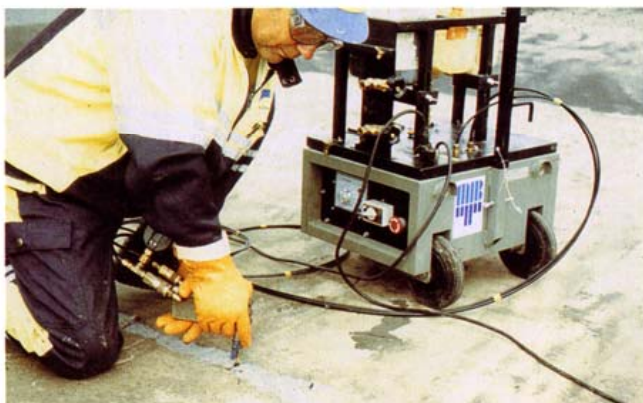
Kuva 1. Epoksi-injektoinnilla saadaan paras lujuus.
