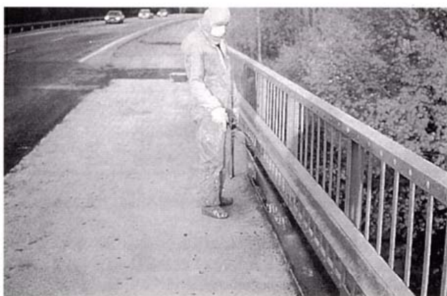
Kuva 2. Impregnointiaine levitetään mieluummin ruiskuttamalla, mutta levitys voidaan tehdä myös siveltimellä.
