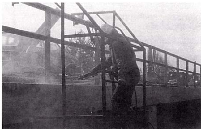
Kuva 1. Impregnoitava pinta suihkupuhdistetaan.
