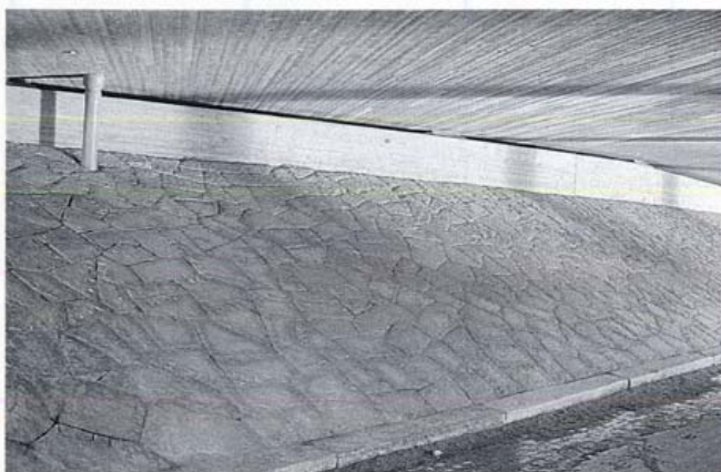
Kuva 3. Etuluiskan kivilaattaverhous (Tampere).
