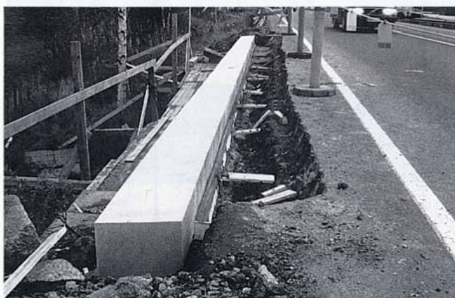
Kuva 2. Luonnonkivistä tehty massiivinen reunapalkki (Maatianjärven silta, Korpilahti).
