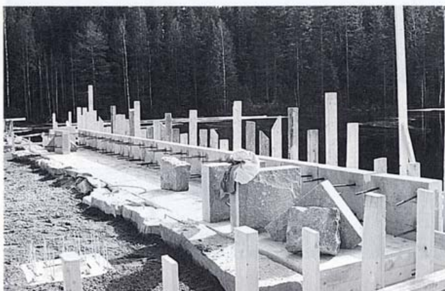
Kuva 1. Sillan reunan verhouuskivet asennettuna (Ah- taansalmen silta, Keuruu).
