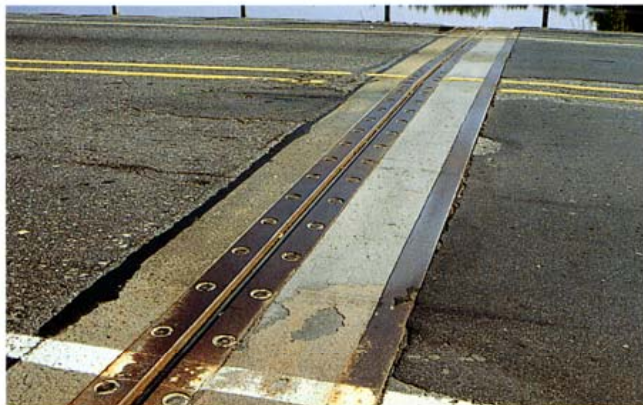
Kuva 2. Keskisuuri liikuntasaumalaite
