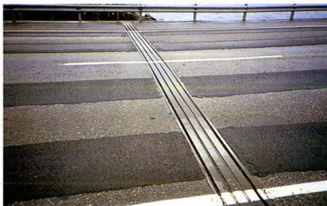
Kuva 3. Suuri liikuntasaumalaite
