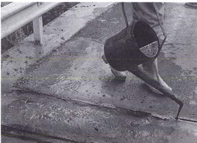
Kuva 3. Päällysteen poikittaissauman saumausta päällysrakenteen pään kohdalla.
