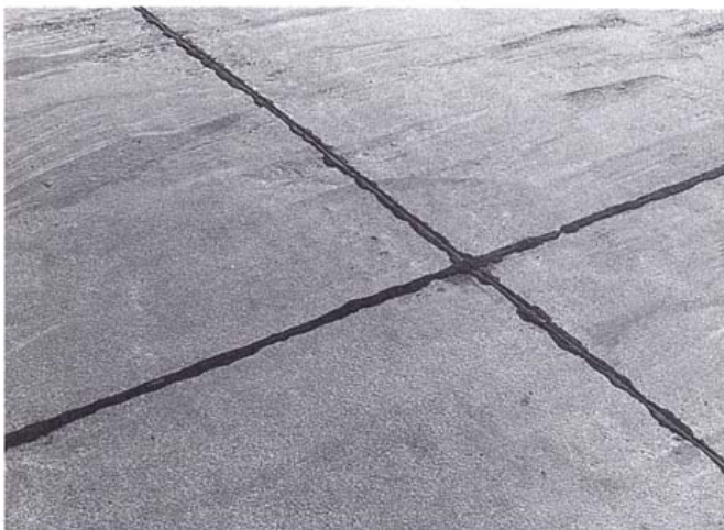
Kuva 8. Teräsbetoniset kansielementit on saumat- tu polymeeribitumilla.
