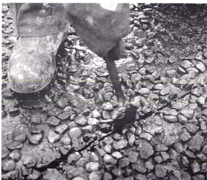
Kuva 6. Valuufaltpäällysteen kutistumissauman esisivelyä.
