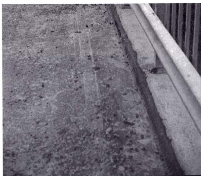
Kuva 5. Päällysteen reunasauama on suljettu polymeeribitumilla.
