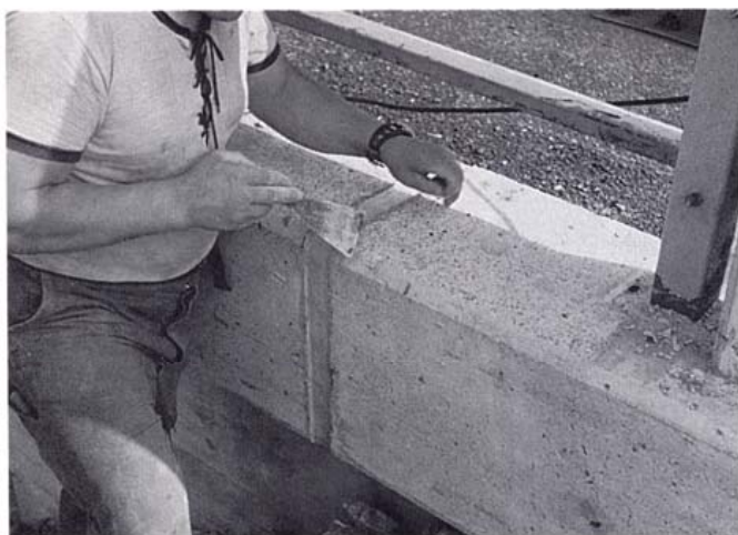
Kuva 2. Alus- ja päällysrakenteen välisen sauman saumausta reunapalkin kohdalla.
