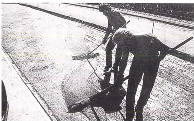
Kuva 3. Kumibitumimastiikin levitystä.
