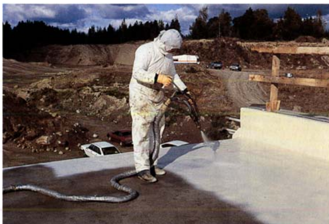
Kuva 1. Polyuretaanin levittämistä ruiskulla.
