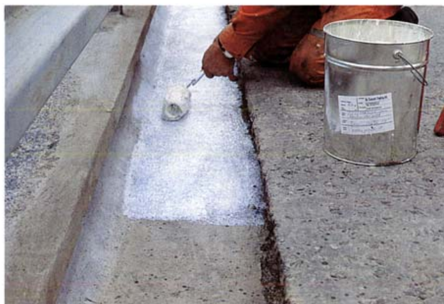
Kuva 2. Epoksimassan levitystä telalla.
