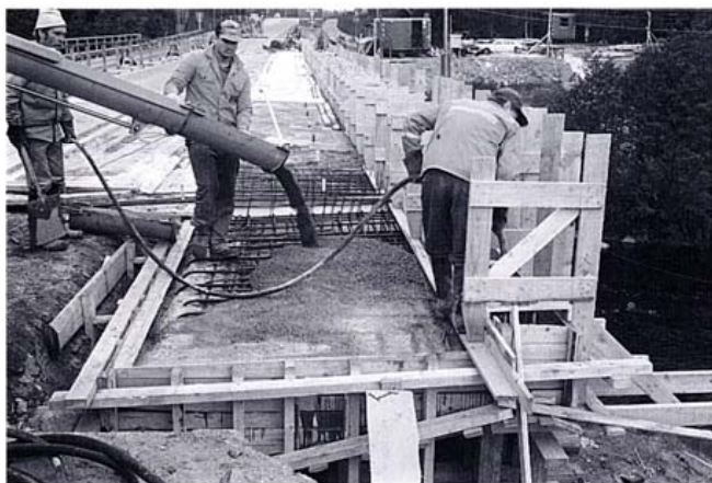
Kuva 1. Sillan vahventamis- ja leventämistyöt sopivat urakoitavaksi.
