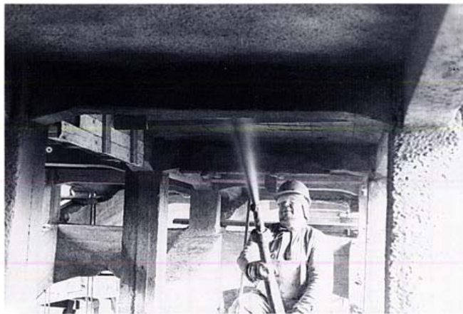
Kuva 3. Ruiskubetonointi on erikoista ammattitaitoa ja kalustoa vaativa työ, joka on yleensä urakoitava.
