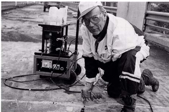
Kuva 2. Mekaanisella pumpulla varustettu muovi-injektointilaitte.
