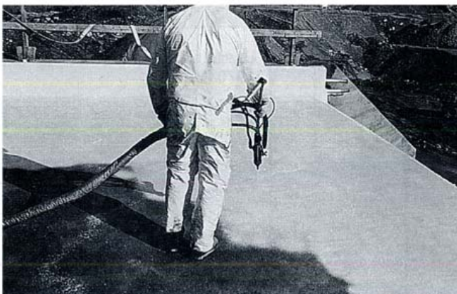
Kuva 3. Eristysmassan ruiskutusta
