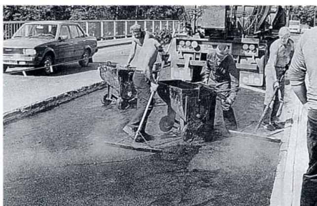
Kuva 2. Eristysmastiksin levitystä.
