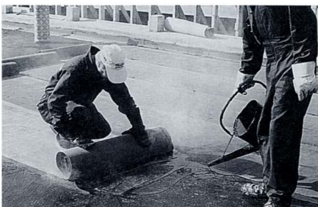
Kuva 1. Kerman kiinnitystä liimaamalla sillan korjauksissa
