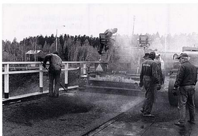
Kuva 2. Päällysteen levitystä.
