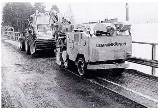
Kuva 1. Päällysteen jyrshintää sillalla.
