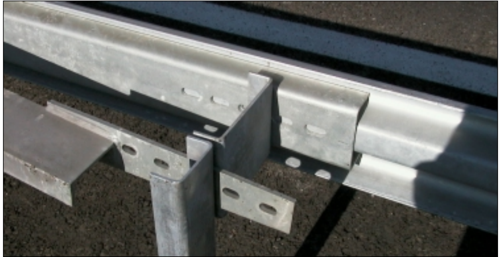
Kuva 11. Siirtymärakenne tiekaiteesta sillankaiteeseen. Johteen takana voidaan käyttää U-140 teräsprofiilia, joka sijoittuu sekä tiekaiteen että sillankaiteen johteen taakse. Käytettäessä tyypikaidetta Ty3/51 kuvassa
