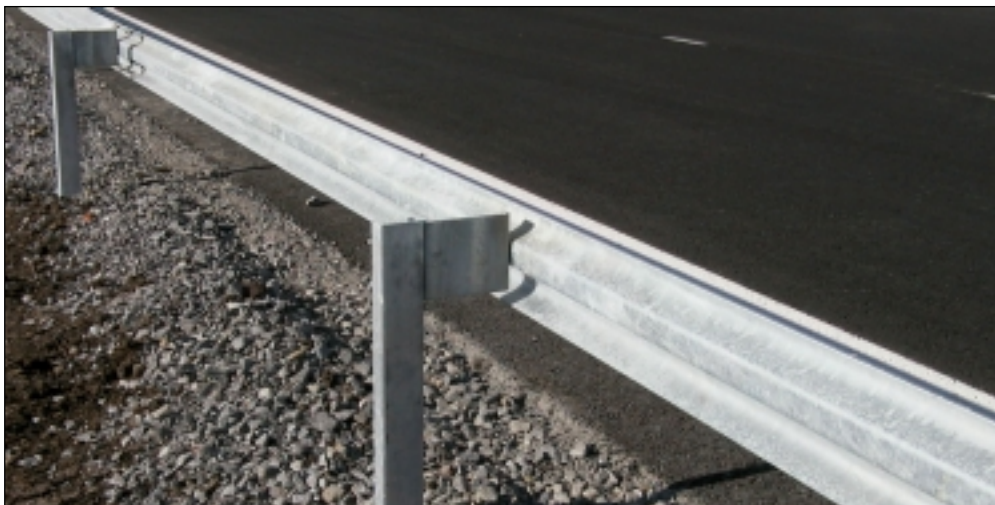
Kuva 5. Loittojohdekaide (entinen Ty 3/53). Ratkaisua on käytetty, kun tien nopeustaso on yli 100 km/h. Loittojohdekaidetta ei ole testattu EN 1317-2 mukaisesti eikä sitä pitäisi käyttää ilman erityistä syytä. Nykyinen tyyppikaide Ty 3/51 (v. 1999) toimii törmäyksessä hyvin ilman loittokappaleita. Nykyisistä loittojohdekaiteista pitäisi poistaa loittokappaleet viisteen osuudelta ja kiinnitys ensimmäisiin pylväisiin pitäisi muuttaa molemmissa päissä nykyisen Ty 3/52 viisteen mukaiseksi, muuten kaide joustaa liikaa ja voi kaatua törmäyksessä.
