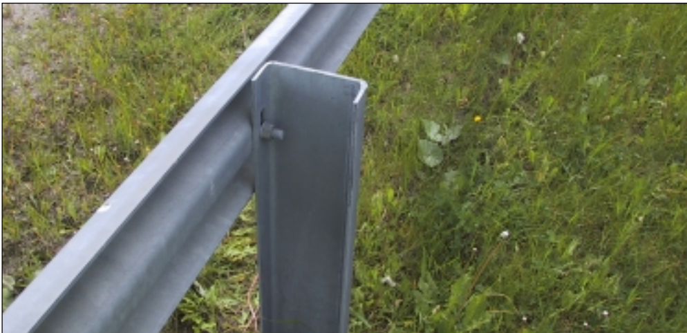
Kuva 3. Tiekaide, jossa pylvään leveys 160 mm (U-160 pylväät) ja kaiteen korkeus 0,55...0,65 m. Suurin osa vuosien 1980 - 1995 välillä rakennetuista kaiteista on tämän tyyppisiä.
