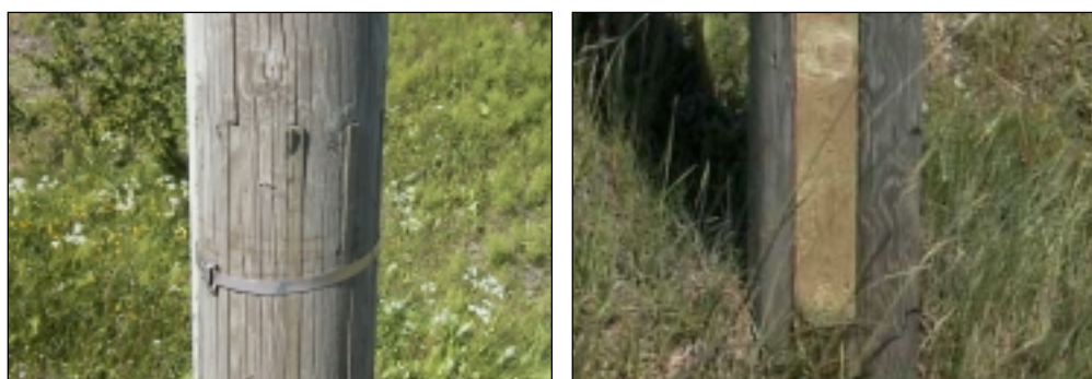
Kuva 31 ja 32. Oikealla sektorisahattu puupylväs (peiterimat) ja vasemmalla ontoksi koverrettu puupylväs (yksi peitelauta pylvään taustapuolella).
