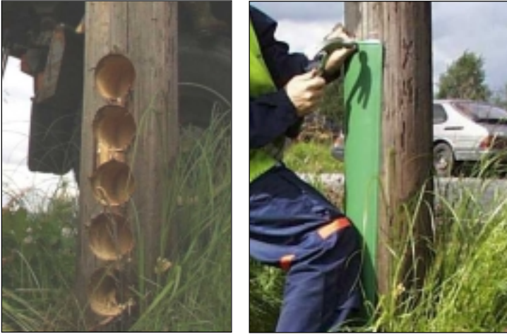
Kuva 35 ja 36. JRK-tekniikalla myötääväksi tehty puupylväs (peltilevy pylväässä).
