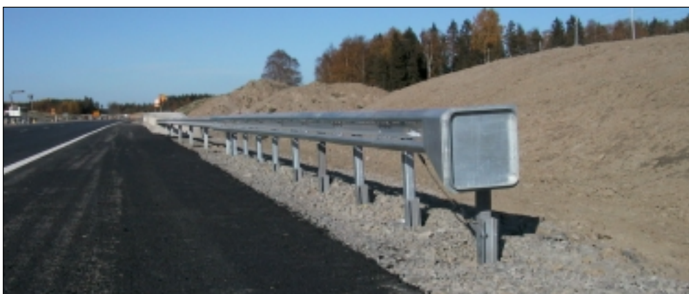
Kuva 8. Kokoon painuva kaiteenpää ABC. Kustannuksen asennettuna noin 20 000 mk (3 400 €). Kokoonpainuva pää ei kaada autoa yhtä herkästi kuin normaali viiste eikä auto pääse liukumaan kaiteen päälle. Vastava turvallisuus saadaan kääntämällä kaiteenpää ulkoluiskaan Ty3/53 (v. 2000) mukaisesti.
