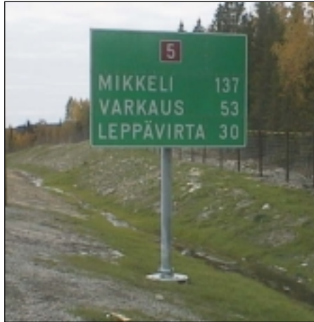
Kuvat 27 ja 28. Törmäysturvallinen liukulaipallinen teräspylväs.
