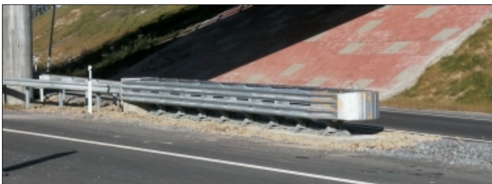
Kuva 9. Siltapilarin eteen asennettu Quad Guard -törmäysvaimennin. Kustannuksen asennettuna noin 100 000 mk (16 800 €). Törmäysvaimenninta käytetään yleensä moottoreilla siltapilarin tai vastaavan esteen edessä, jos ennen estettä ei voida rakentaa riittävän pitkää kaidetta. Kuvassa erkanemiskaista on siltapilarin ja sillan maatuon välissä.
