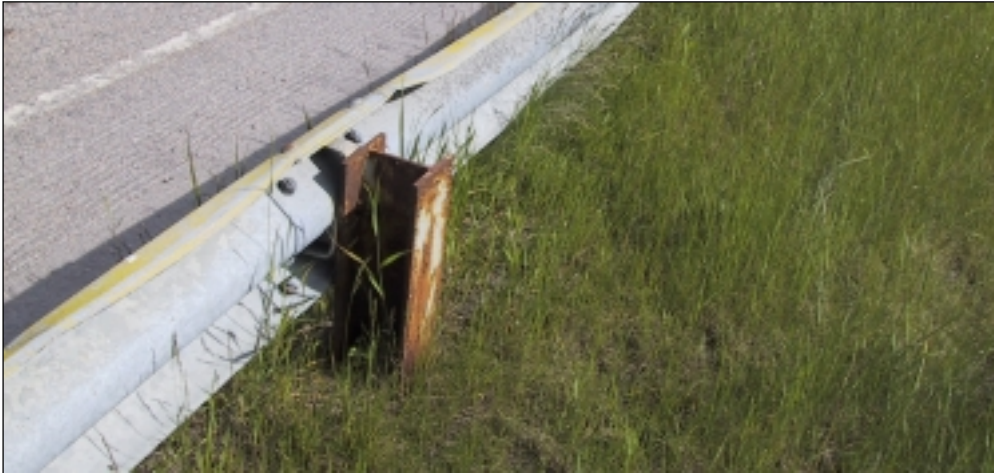
Kuva 2. Tiekaide, jossa I-pylväät ja kaiteen korkeus alle 0,55 m.
