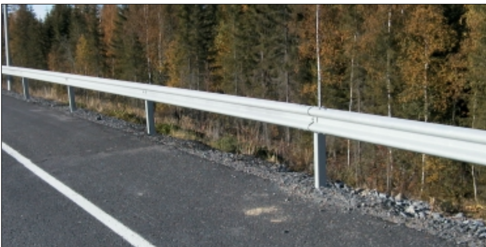
Kuva 4. Nykyaikainen tyyppikaide Ty3/51, jossa pylvään leveys on 100 mm (U-100 pylväät) ja kaiteen korkeus 0,7 m päällysteen reunasta.
