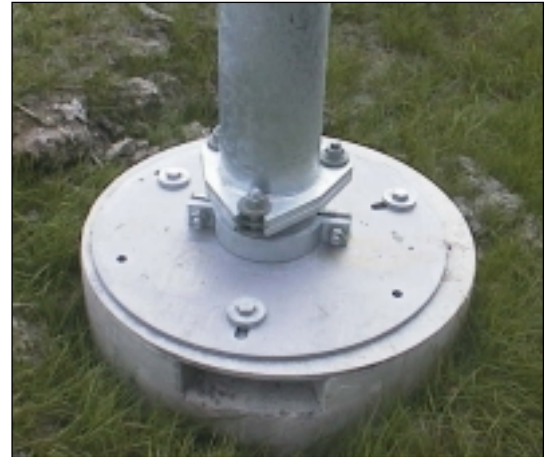
Kuvat 27 ja 28. Törmäysturvallinen liukulaipallinen teräspylväs.
