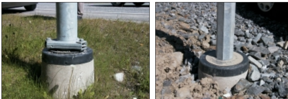
Kuva 29 ja 30. Vasemmassa kuvassa on liukulaipallinen metallipylväs ja oikeassa kuvassa on monikulmainen metallipylväs (KAPU-teräspylväs). Pylvään betoniantura ei saa olla yli 30 cm maanpintaa korkeammalla.
