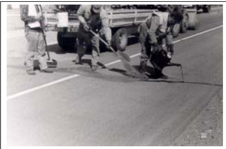
Kuva 14. Halkeaman korjaus kannukaatosauhausmenetelmällä.
