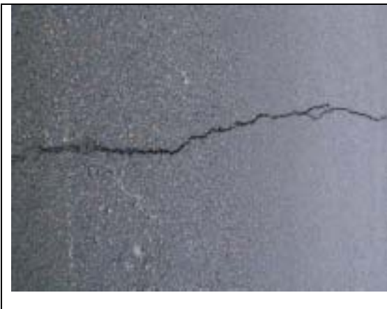
Kuva 10. Poikittainen halkeama.
