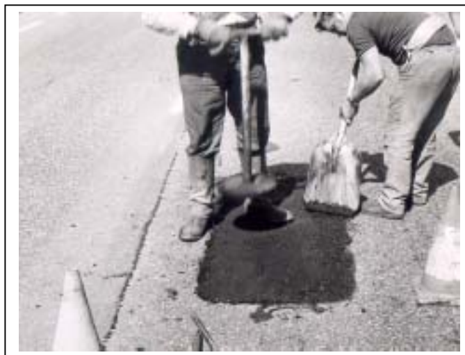
Kuva 3. Asfalttibetonipaikkaus käsityömenetelmällä.
