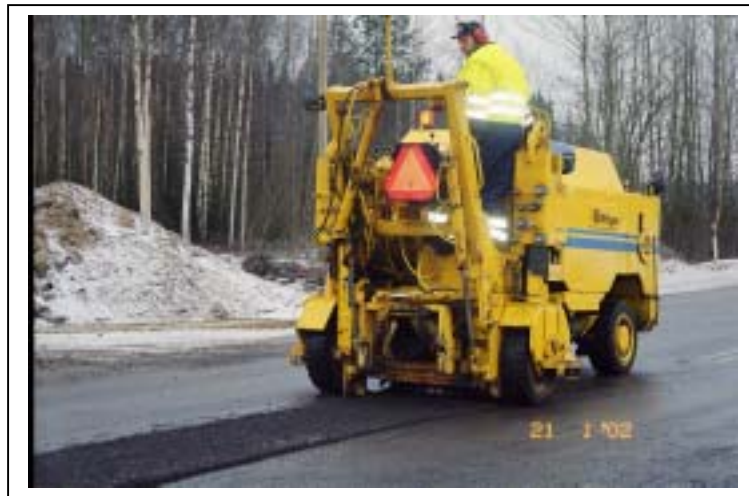
Kuva 15. Asfalttipinnan vauriokohdan kylmäjyrsintä.
