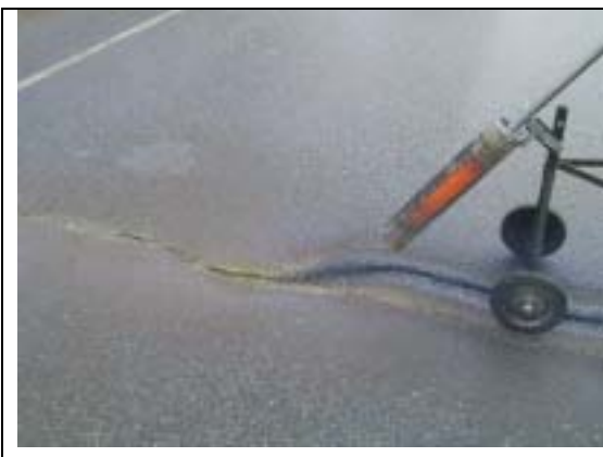
Kuva 12. Puhalluskuumennus.
