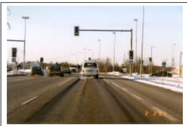
Kuva 1. Asfalttipäällysteen deformaatiouria.
