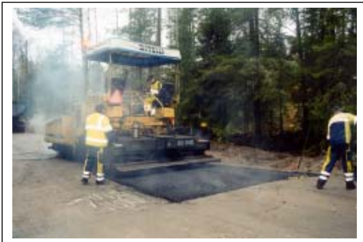
Kuva 4. Asfalttibetonipaikkaus konetyömenetelmällä
