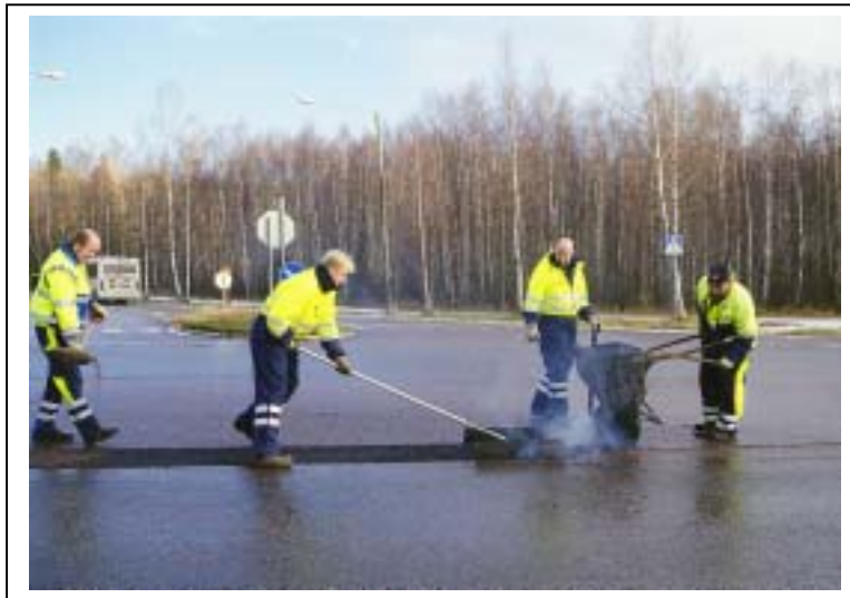
Kuva 5. Valuasfalttipaikkaus käsityömenetelmällä.
