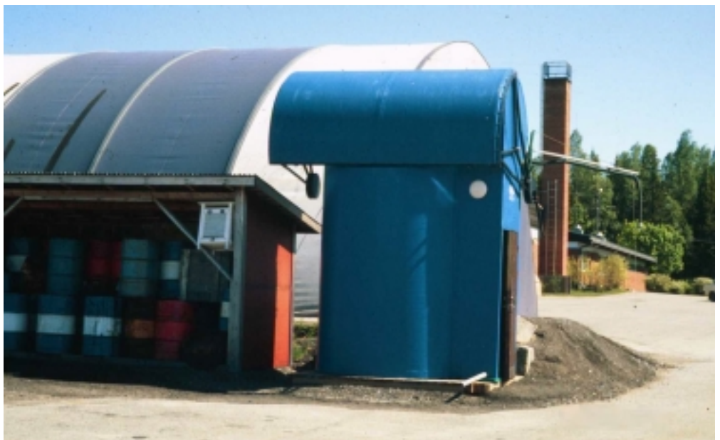
Kuva 25. Liuosasema sijoitettuna suolahallin ulkopuolelle. Vastaavasta asemasta on rakennettu myös helposti siirrettävä kuljetuskonttimalli.
