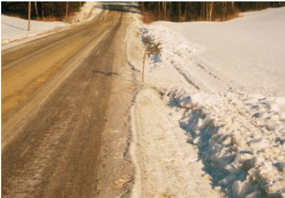
Kuva 15. Soratien reunan kevään lumitöillä ehkäistään pintakelirikkoa.
