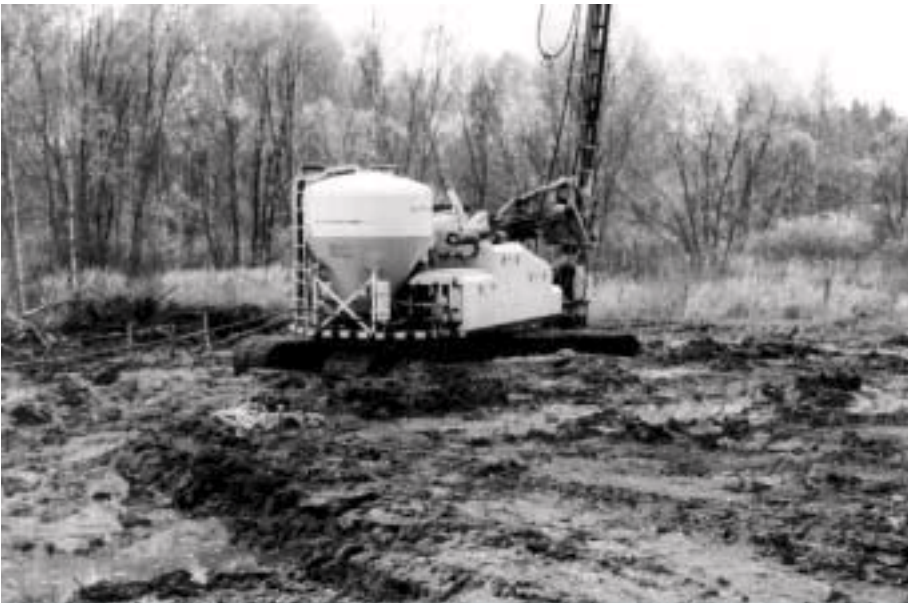
Kuva 5.5 Lujien pilarien teko oli hankalaa: pilarikone "ui", vaikka seisoikin isojen levyjen päällä.
