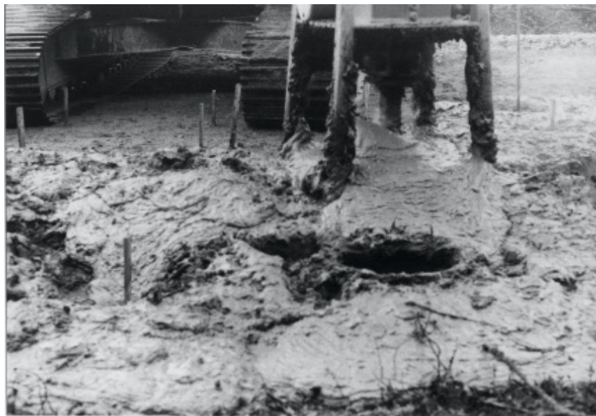
Kuva 3.12 Pilaroinnin yhteydessä savi nousi puolen metrin hiekkakerroksen läpi – toisissa kentissä hyvinkin juoksevana, toisissa sideaineen vaikutuksesta vähän jähmeämpänä.
