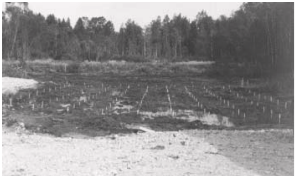
Kuva 5.1 Puoliluja pilarikenttä odottaa pilarikonetta. Pilarointityö aloitettiin kuvan etulaidasta. Kuvan suunta itään.
