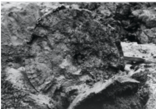
Kuva 3.23 YIT-Yhtymä Oy:n kentästä nostettu pilarinpala noin syvyysväliltä 3,8–4,5 m. Tässä palassa näkyy keskellä reikä, muissa paloissa ei näkynyt. Suuria keltaisia sideainekasautumia.
