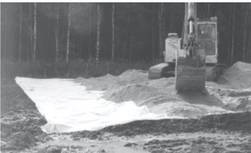
Kuva 5.3 Tiivistyspedin tekoa juuri massastabiloidun alueen päälle.
