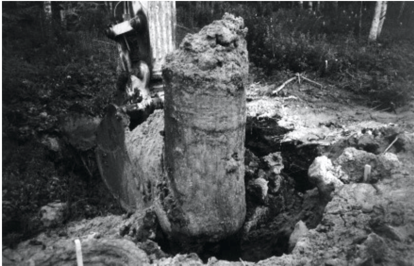
Kuva 3.15 Pilarin yläpään nostaminen kaivinkoneella.
