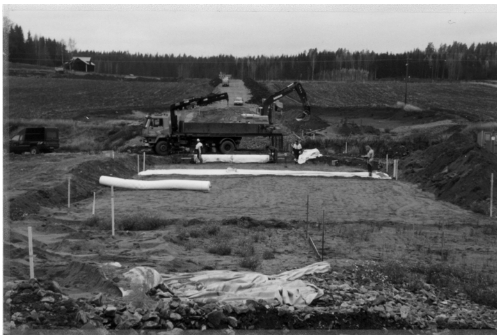
Kuva 4.1 Hertsby. Geovahvistusten asentaminen. Kuva otettu 24.10.1996 kasvavan paalulukeman suuntaan, Sipoonjoki kuorma-auton takana.
