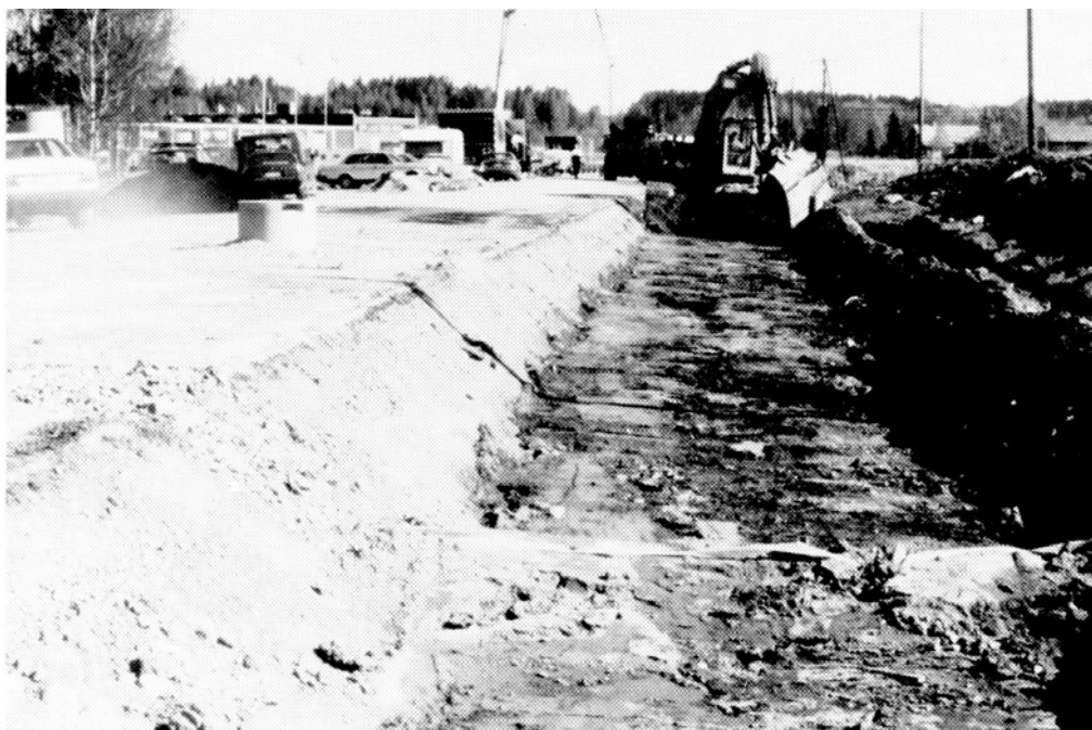
Kuva 4.1 Mikonkorpi. Vanhan tiepenkereen ja rakennekerrosten leikkaus vanhan alusrakenteen yläpintaan saakka. Kuva noin paalulta 250 kasvavan paalulukeman suuntaan (23.5.1996), [Viatek-Yhtiöt Oy 1997].
