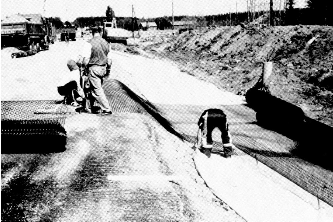
Kuva 4.2 Mikonkorpi. Suodatinkangas kl3 ja osa pussirakenteen alaverkoista levitettynä levennyksen pohjalle (23.5.1996), [Viitek-Yhtiöt Oy 1997].
