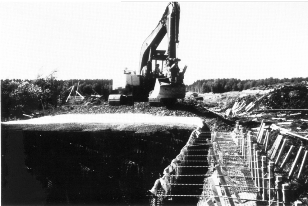
Kuva 4.2 Leteensuo, Geosellirakenne. Tukipenkereiden ja kantavan kerroksen rakentaminen käynnissä. Edessä kevytsoralla täyttämätöntä geosellirakennetta [Viatak 1997].
