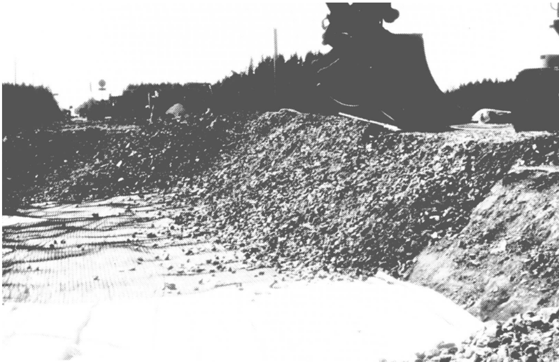
Kuva 4.3 Mikonkorpi. Jakavan kerroksen kalliomurskeen 0/100 levitys pussirakenteen alaverkon päälle. Levitys tapahtuu vanhasta penkereestä ulospäin (23.5.1996), [Viitek-Yhtiöt Oy 1997].
