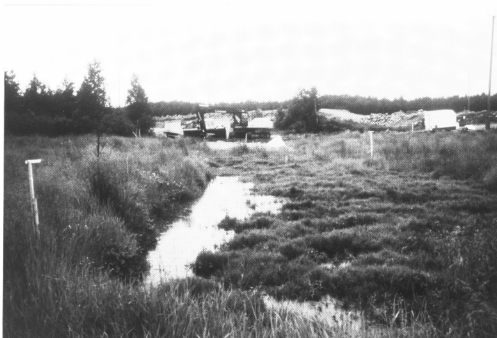
Kuva 4.3 Leteensuo, plv noin 590-620. Pohjamaa tasattuna 2 × vahviste + LECA -rakenteen kohdalla. Kuva otettu 9.7.1996 paalulta noin 620 alenevan paalulukeman suuntaan [Viitek 1997].
