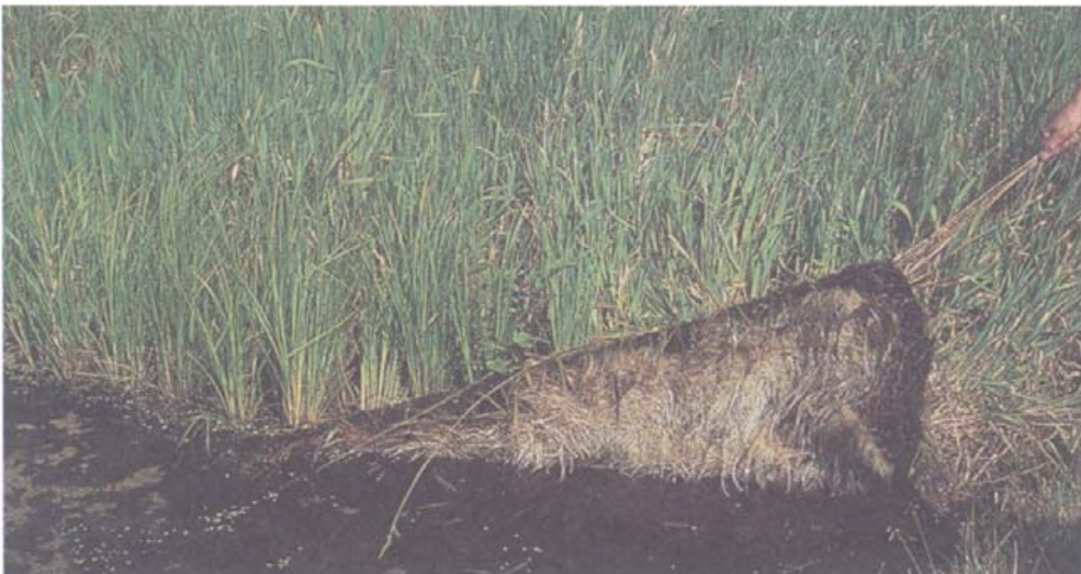
Kuva 26: Kaikki viherrakenteet voidaan yhdistää eroosiomattoihin ja -verhouksiin etenkin, jos käytetään maatuvia eroosiontorjuntamateriaaleja.
