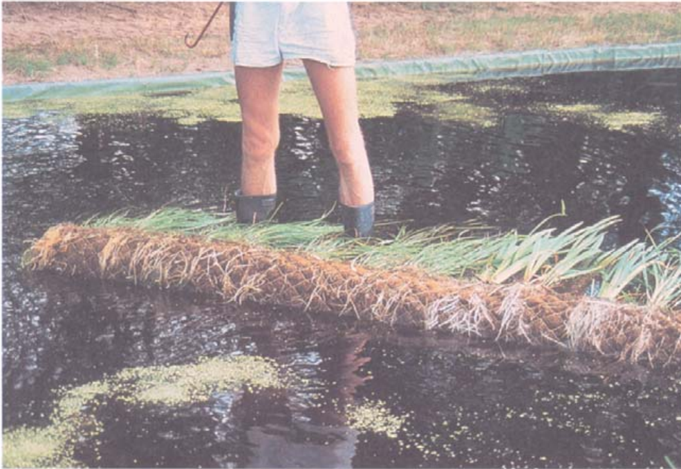
Kuva 25: Vesieroosion vaivaamille kasvupaikoille voidaan istuttaa rulliin tai mattoihin kasvatettuja taimia, joita tällä hetkellä on saatavilla ainakin Ruotsin markkinoilla.
