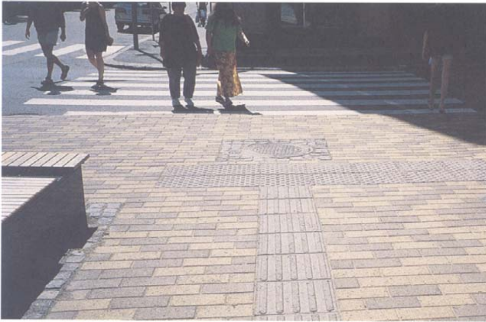
Kuva 10: Jyväskylän kävelykadulla näkövammaisten kulkua ohjaavat raitalaatta ja risteyksissä varoittava nappulalaatta. Vastaavaa tunnistettavaa kuvioraitaa voi toteuttaa karkeapintaisella, ympäristöstä poikkeavalla pinnoitteella. Kaikissa ratkaisuissa on vaarana talvikunnossapidon aiheuttama pinnan rikkoutuminen.
