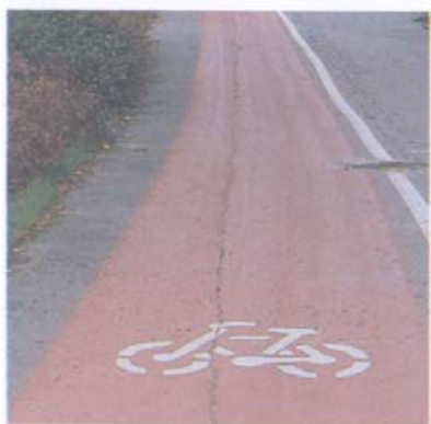
Kuva 23: Värillisen asfaltin käytössä on ongelmia paikkauksessa ja punaisen värin liian voimakkaassa erottumisessa muusta ympäristöstä. Kuvassa on värillinen pinta.
