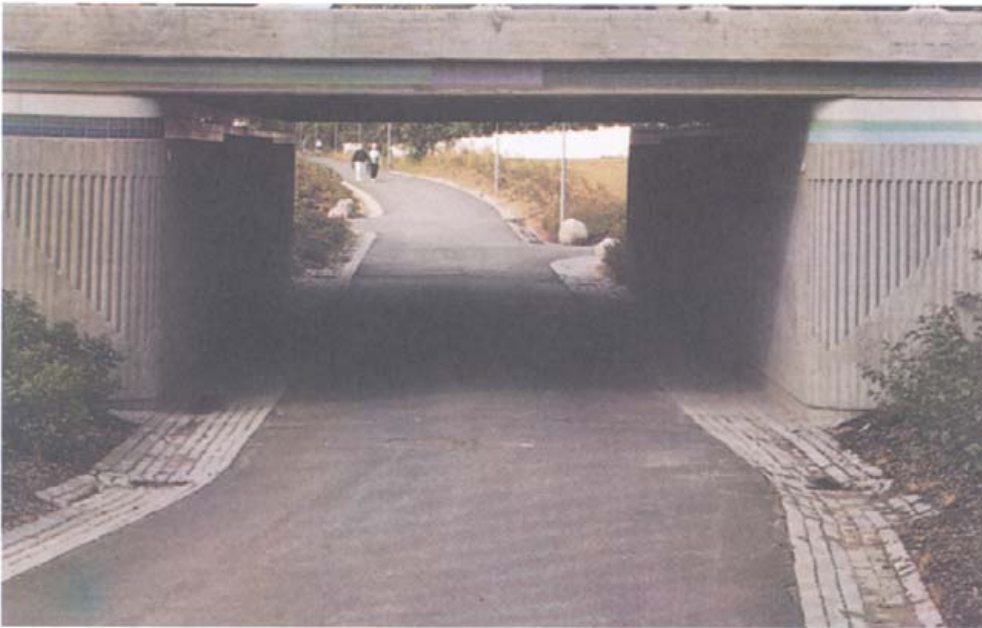
Kuva 22: Kevyen liikenteen väylän ja sillan etuluiskan väliin jäävän sadevesipainanteen on suositeltavaa erottua selkeästi. Sillan keilat on verhoiltava siten, ettei kiviä voi irrottaa.
