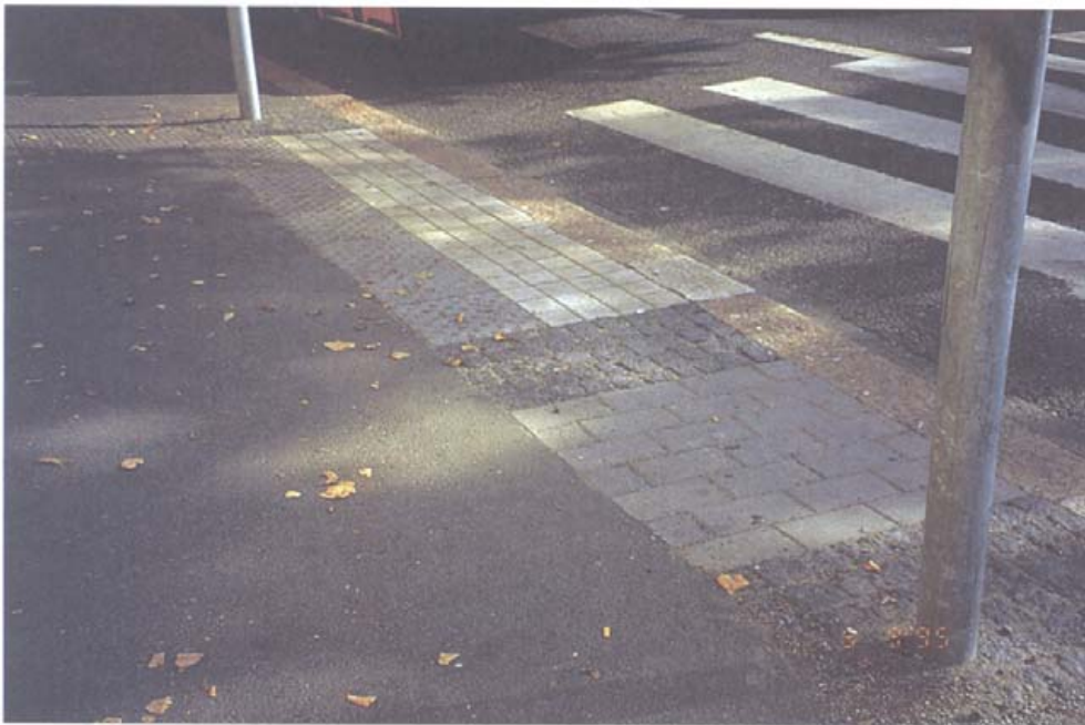
Kuva 11 : Helsingin Mäkelänkadun - Elimäenkadun liittymässä on tehty kokeiluristeyalue, jossa erilaiset liikkumisesteiset testaavat reunakiven korkeuksia ja eri pintamateriaalien toimivuutta.
