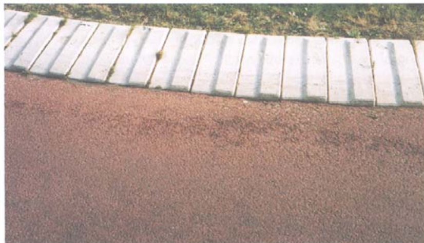
Kuva 36: Leveä, noin 300 mm, aallotettu reunatuki, jonka päälle voi ajaa pitkällä kuorma-autolla liittymän sisäkaarteessa tai kiertoliittymän saarekkeessa. Henkilöautoa reunatuki täristää voimakkaasti. (Tanska)
