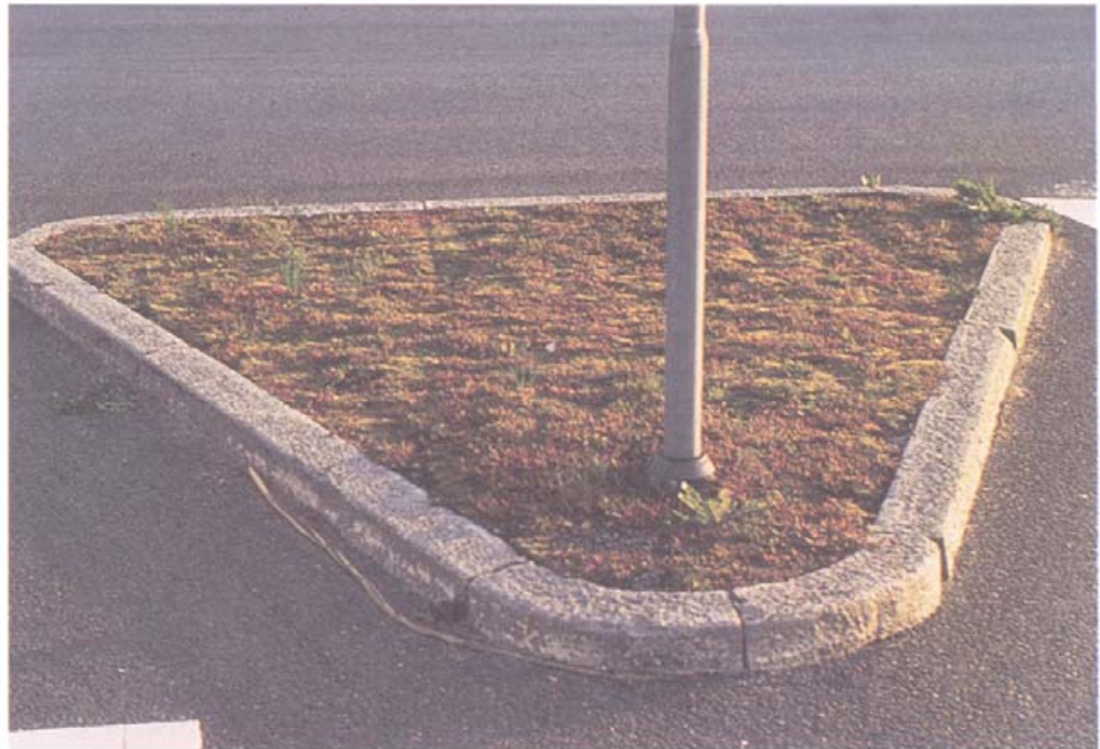
Kuva 27. Liikenteenjakkajien verhouksiin sopivaa asennusvalmista maksaruohomattoa on tarjolla ainakin Ruotsin markkinoilla. Maton alla on karkea sepeli rikkaruohojen kasvun estämiseksi. Se soveltuu Lounais-Suomeen, mutta ei kestä lähellä voimakkaasti suolattuja teitä eikä kuorma-autojen yliajtoa.
