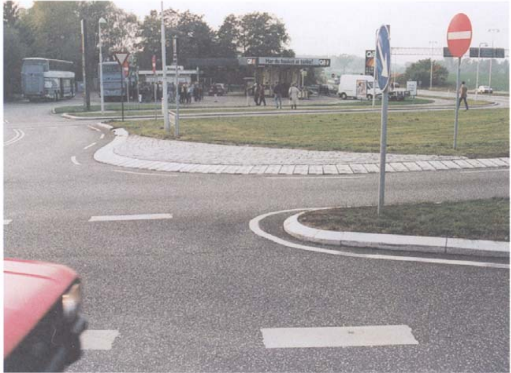
Kuva 19. Tanskassa on toteutettu yliajettavia saarekkeita aallotetulla reunatuella ja epätasaisilla pintamateriaaleilla.
