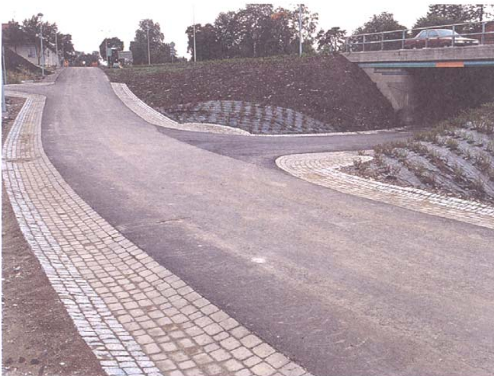
Kuvat 46-47: Erilaisia koururatkaisuja Tuusulanväylällä.
