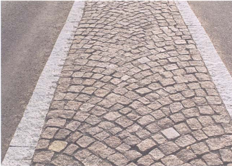
Kuva 18: Nupukivellä verhoiltu saareke.
