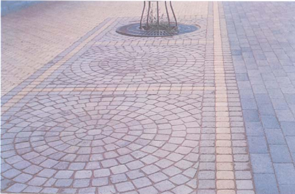
Kuva 28: Esimerkkikuvat ladonnasta, jossa on noudatettu nykyisiä asennustoleranssisuosituksia.
