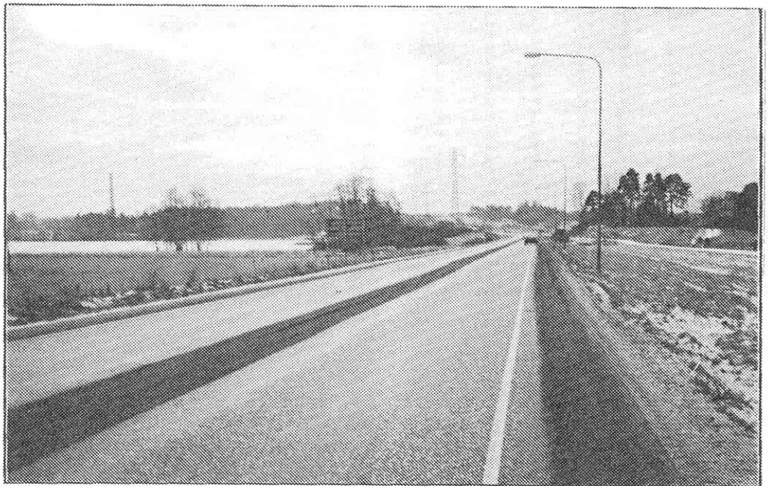
Kuva 1. Esimerkki painumaerosta perustamistapojen vaihtumiskohdassa.
