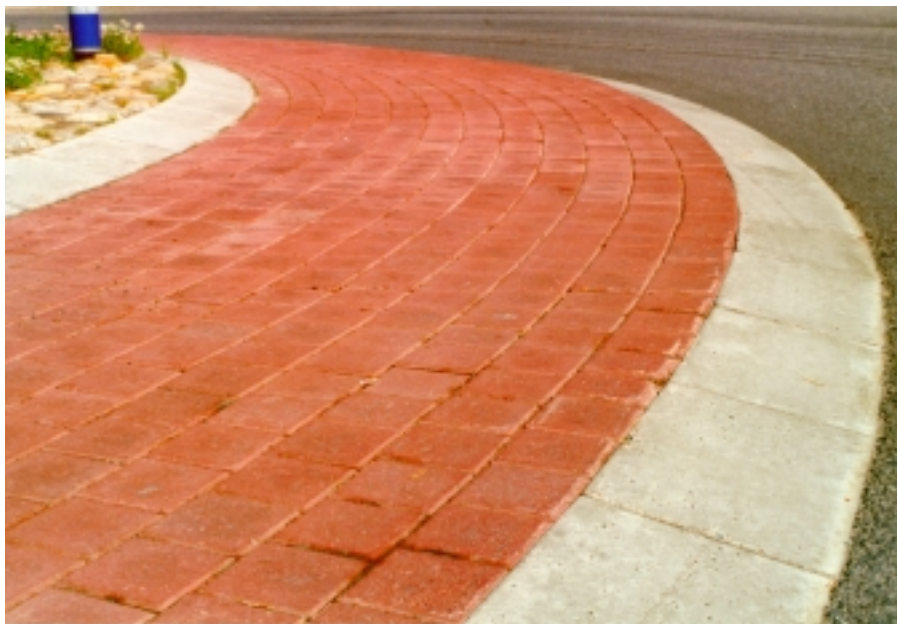
Kuva 4: Kiertotilan kavennus Kulhon kiertoliittymässä Joensuussa. Viistettyä reunatukea valmistaa mm. Lujabetonin Joensuun tehdas.
