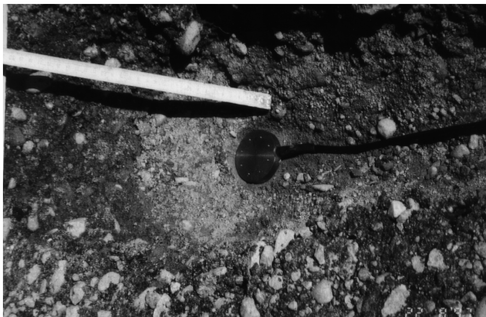
Kuva 4. Jakavaan kerrokseen asennettu paineanturi.
