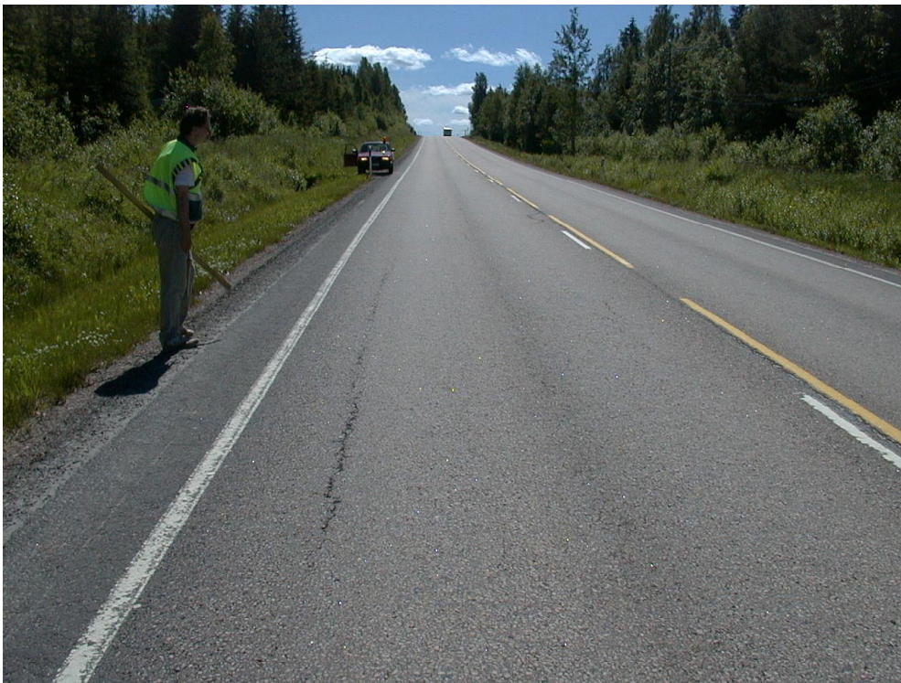
Kuva 20. Koeosuuden 5 rakenteiden saumakohdassa havaittu halkeama, joka oli ainoa uuden ja vanhan rakenteen saumakohdassa havaittu koe- ja vertailuosuudetkin huomioiden.
