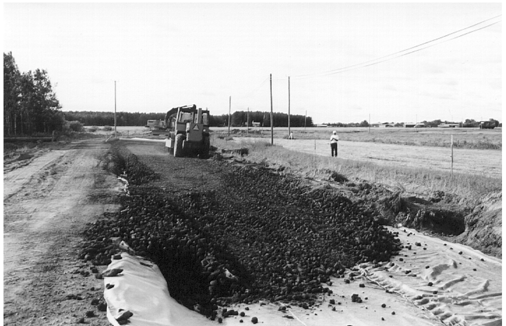
Kuva 9. Palaturpeen tiivistäminen valssitäryttimellä.
