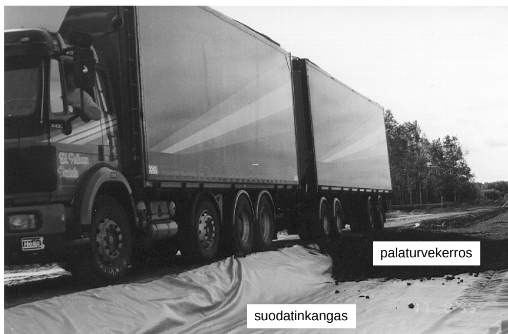
Kuva 7. Suodatinkangas levitettynä muotoillun alusrakenteen pinnalle tien oikealla kaistalla.
