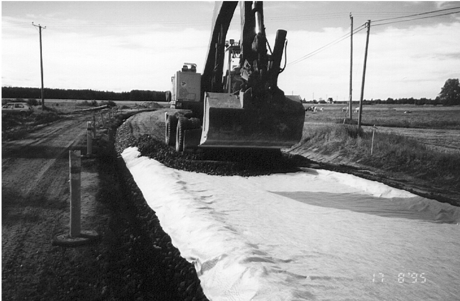
Kuva 10. Kantavan / jakavan kerroksen levitys ja muotoilu pyöräalustaisella kaivinkoneella.
