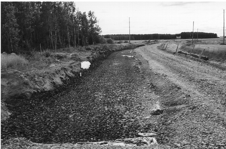
Kuva 11. Koerakenteen vasemman kaistan palaturvekerros tiivistettynä 21.8.1996. Liikenne kulki oikealla kaistalla kantavan (KaM) kerroksen päällä.
