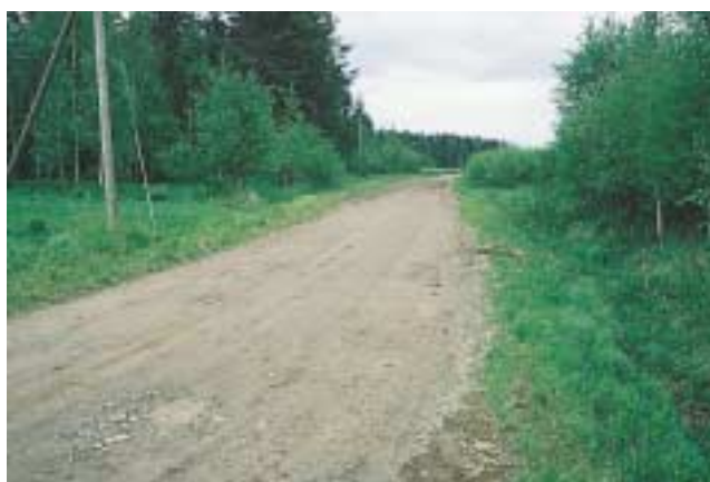
Kuva 12: Raiteet, kuopat, irto- ja maakivet Tiessä on liikennettä ja kunnossapitoa haittaavia kuoppia, arvosana 1 (arvo- sanat 2–0).
