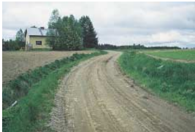
Kuva 11: Reunapalteet Reunapalteet haittaavat tien kuivatus- ta, arvosana 0 (arvosanat 1 tai 0).
