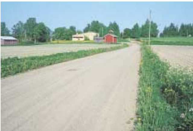
Kuva 6: Materiaalin laatu Kulutuskerrosmateriaalia on hyvää, arvosana 3 (arvosanat 3–0).
