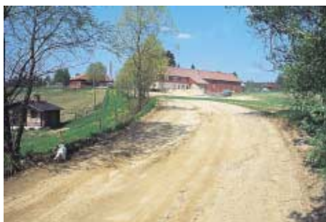
Kuva 13: Raiteet, kuopat, irto- ja maakivet Tiessä on pahoja painaumia, arvosana- 0 (arvosanat 2–0).
