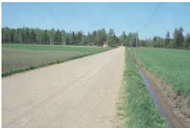
Kuva 10: Sivukaltevuudet Poikkileikkausmuoto on hyvä, arvosana 1 (arvosanat 1 tai 0).
