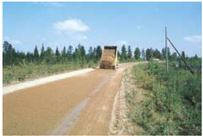
Kuva 45: Soran levitystä kuorma-autosta.
