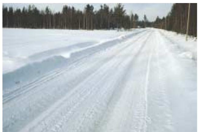
Kuva 21: Raiteet, polanne ja liukkaus Raiteet vaikeuttavat ajamista huomattavasti, arvosana 0 (arvosanat 1 tai 0).
