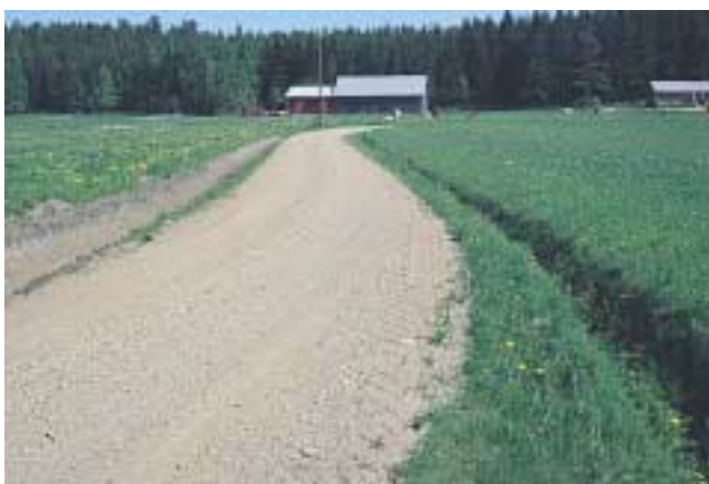
Kuva 8: Materiaalin määrä Kulutuskerrosmateriaalia on riittävästi, arvosana 3 (arvosanat 3–0).
