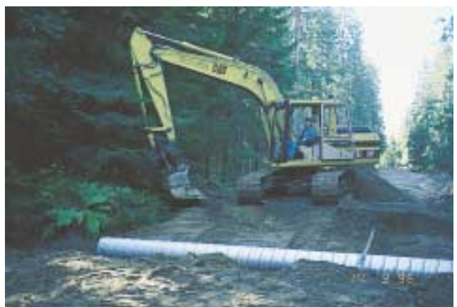
Kuva 49: Rummun uusiminen.
