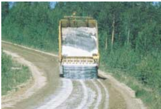
Kuva 29: Kalsiumkloridin levitystä kuorma-autosta.
