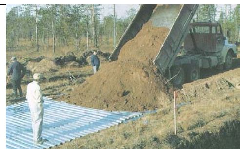
Kuva: Teräsprofilin käyttö
