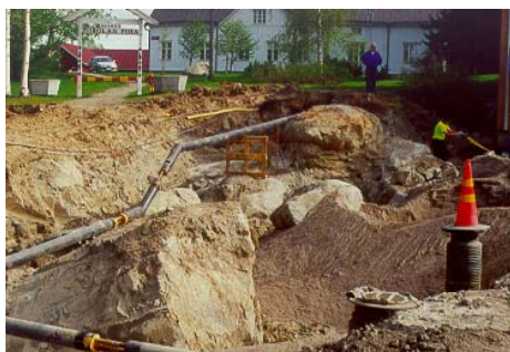
Kuva: Maakivi tierakenteessa
