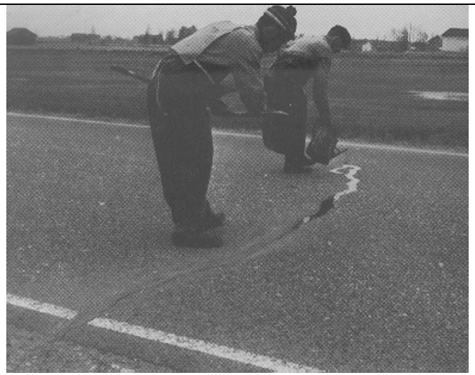
Kuva: Rakenteen korjaaminen bitumiliuksella.
