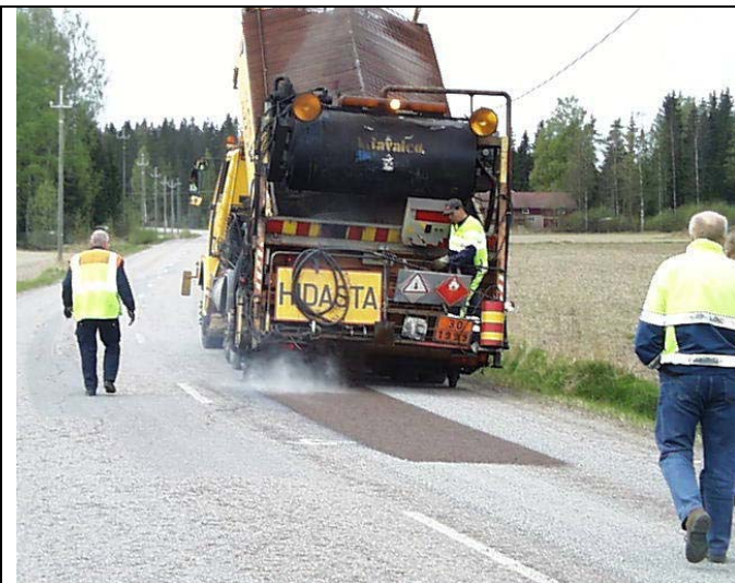
Kuva: Soratienpintausten korjaukseen tarkoitettu laitteisto.
